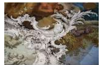
Ny.II, Gartensaal beim Festsaal, R. 1, Deckenfresko und Stuck, DI029019, BSV-
