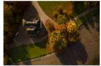
Ny.I, Luftaufnahme der Badenburg, DI028899, BSV-
