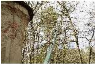
NyMa.I, Baumarbeiten, Magdalenenklausen, DI018784, BSV-
