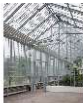
NyEi.II, Eisernes Haus, DI001514, BSV
