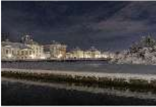
Ny.I, Hauptschloss, Stadtseite, Blick von Südosten, DI029574, BSV-
