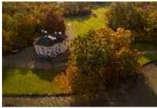
Ny.I, Luftaufnahme der Badenburg, DI028896, BSV-
