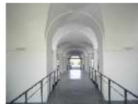
Ny.II, Eingang West, nicht eingerichtet, DI001485, BSV
