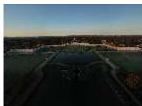
Ny.I, Luftaufnahme vom Schloss von der Stadtseite aus, DI028881, BSV-
