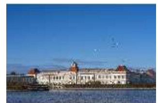
Ny.I, Orangerietrakt und Johannisbrunnhaus-Turm, DI029250, BSV-
