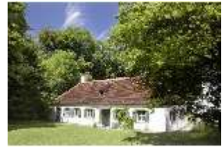
Ny.V, Dörfchen, Brunnwärterhaus, DI001615, BSV
