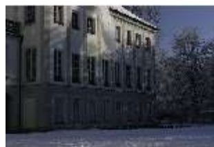
Ny.V, Schneelawine vom Dach der Gartenfassade im Winter, DI007196, BSV-
