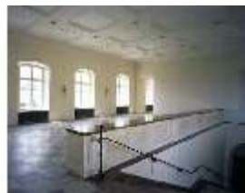
Ny.II, Orangerietrakt, Treppenhalle vor Hubertussaal, DE002873, BSV-
