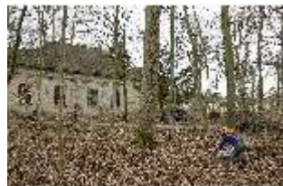
NyMa.I, Baumarbeiten, Magdalenenkloster, DI018769, BSV-
