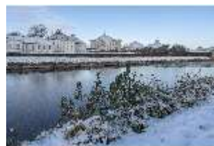
Ny.I, Hauptschloss von der Stadtseite, südöstlicher Kanalarm, DI029209, BSV-
