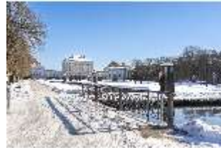
Ny.V, Großes Parterre und Gartenfassade, Winter, DI029654, BSV-
