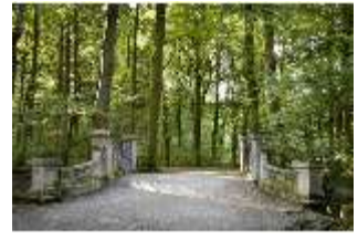
Ny.V, Brücke (beim Dörfchen, Kammerschleuse), DI001612, BSV
