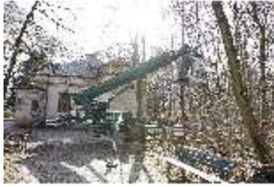
NyMa.I, Baumarbeiten, Magdalenenklausen, DI018776, BSV-
