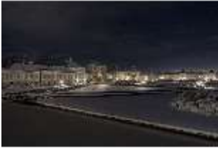
Ny.I, Hauptschloss, Stadtseite, Blick von Südosten, DI029580, BSV-
