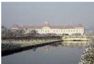
Ny.V, südlicher Wassergang, Orangeriebau im Winter, DI008597, BSV-
