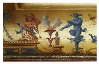
NyPa.II, Hohlkehle mit Chinoiserien im Obergeschoss, DI016322, RSV
