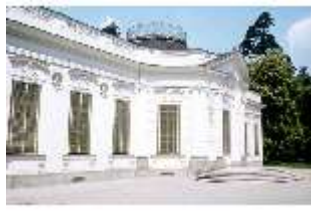
NyAm.I, Ansicht von Südosten mit Belvedere, DE003985, BSV
