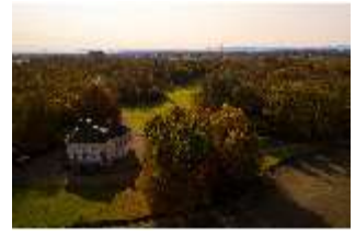
Ny.I, Luftaufnahme der Badenburg, DI028895, BSV-
