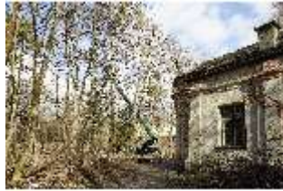
NyMa.I, Baumarbeiten, Magdalenenklausen, DI018781, BSV-
