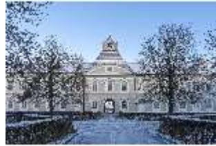
Ny.I, Hauptverwaltung, verschneiter Innenhof, DI029214, BSV-
