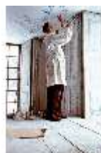
NyAm.II, Hundekammer, R.1, Restaurierung der Decke, DE003990, BSV
