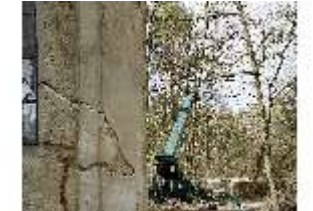
NyMa.I, Baumarbeiten, Magdalenenklausen, DI018785, BSV-
