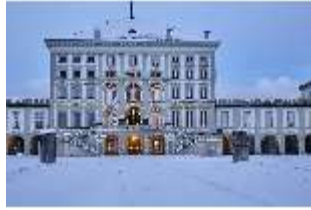
Ny.I, Abendstimmung an der verschneiten Ostfassade, DI008599, BSV-
