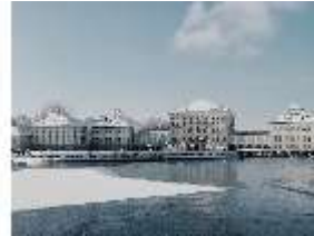
Ny.I, Stadtfassade, Bassin im Schnee, DI029049, BSV-
