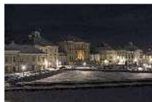
Ny.I, Hauptschloss, Stadtseite, Blick von Südosten, DI029578, BSV-
