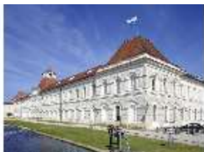
Ny.I, Orangerietrakt, Blick zum Johannisbrunnhaus-Turm (von Südost), DI001620, BSV
