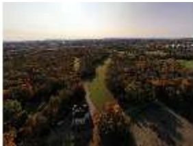
Ny.I, Luftaufnahme der Badenburg, DI028900, BSV-
