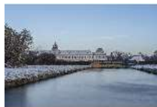
Ny.I, Orangerietrakt und Johannisbrunnhaus, DI029260, BSV-
