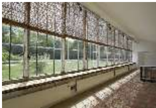
NyGe.II, Geranienhaus, Raumansicht, DI015937, BSV
