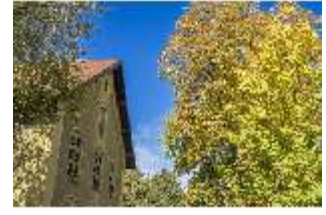
Ny.V, Gebäude südlich der Schlösserverwaltung, DI028475, BSV-
