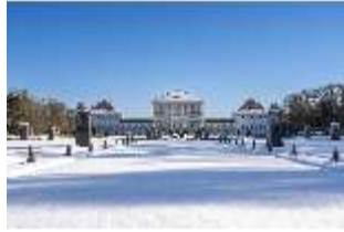
Ny.V, Großes Parterre und Gartenfassade, Winter, DI029586, BSV-
