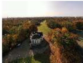
Ny.I, Luftaufnahme der Badenburg, DI028901, BSV-
