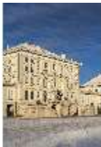
Ny.I, Mittelbau des Hauptschlusses, Stadtseite, DI029222, BSV-
