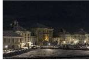
Ny.I, Hauptschloss, Stadtseite, Blick von Südosten, DI029582, BSV-
