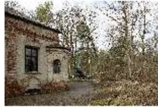
NyMa.I, Baumarbeiten, Magdalenenklausen, DI018782, BSV-
