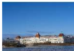
Ny.I, Orangerietrakt und Johannisbrunnhaus-Turm, DI029248, BSV-
