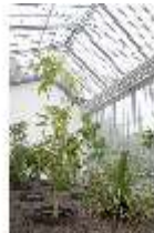
NyEi.II, Eisernes Haus, DI001510, BSV
