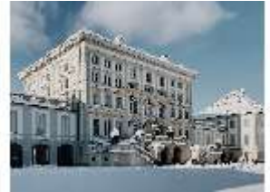
Ny.I, Stadtfassade, Mittelbau im Schnee, DI029046, BSV-
