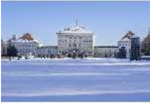
Ny.V, Großes Parterre und Gartenfassade, Winter, DI029589, BSV-
