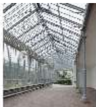
NyEi.II, Eisernes Haus, DI001513, BSV
