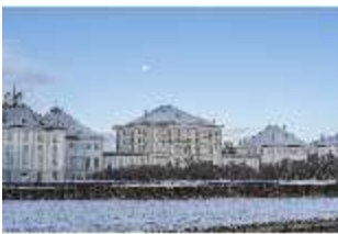
Ny.I, Hauptfassade, Blick vom südöstlichen Kanalarm, DI029207, BSV-
