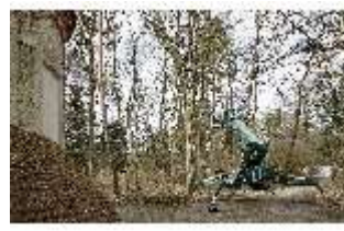
NyMa.I, Baumarbeiten, Magdalenenklausen, DI018786, BSV-
