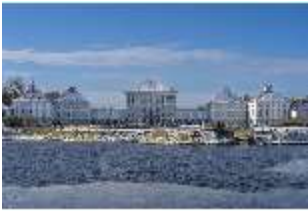
Ny.I, Fassade des Schlosses von der Stadtseite, DI029262, BSV-
