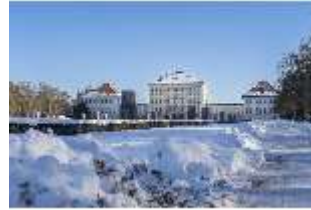
Ny.V, Großes Parterre und Gartenfassade, Winter, DI029591, BSV-
