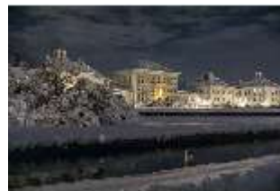
Ny.I, Hauptschloss, Stadtseite von Südost, Nachtaufnahme, DI029550, BSV-
